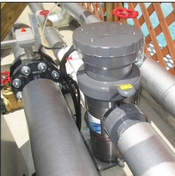
▲施工現場写真
